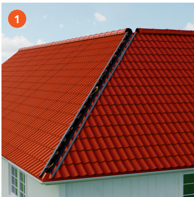
Montera tätbandet Universal mellannock och takpanna.
