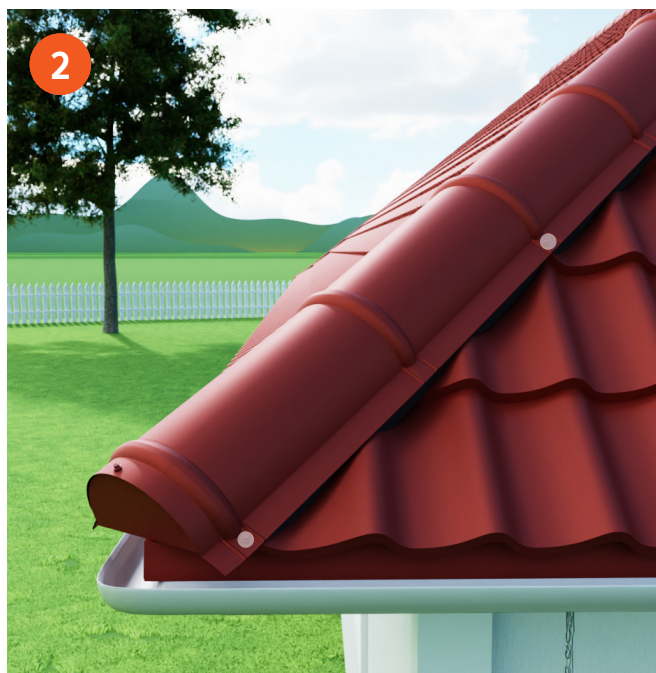
Placera en nockplåt och ett ändlock längst ner och fäst ändlock på samma sätt som i montering av nockplåt. Nockplåten monteras med överlappsskruv i var 3:e profiltopp.
